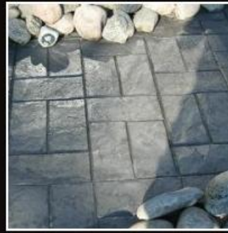
Skiffersten Storlek ca 15 x 30 cm. Betongen genomfärgad svart. Mönstret finns som gummimatris.
