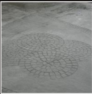
Gatstencirklar i form som blomma bredden på två cirklar ca 300 cm. Betongen genomfärgad svart. Mönstret finns som gummimatris.
