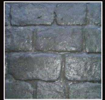
Sliten gatsten i förband med breda fogar. Bredden på stenen ca 13 cm, längden varierande. Betongen genomfärgad svart. Mönstret finns som gummimatris.
