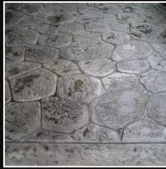
Random mönster med slät fräs. Färgad genom inskurning av hårdcement samt pigmenterad släppvätska. Mönstret finns som gummi matris.
