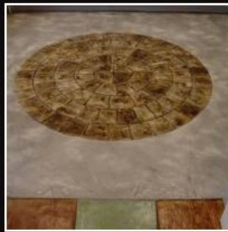
Gatstencirkel ca 150 cm i diameter. Infärgad med betongetsning, svart. Mönstret finns som matris.
