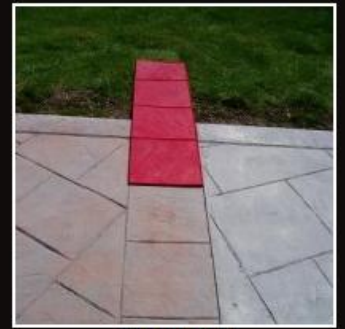
Skifferbård stenstorlek ca 30 x 30 cm. Inskurd hårdcement i ytan. Mönstret finns som gummimatris.
