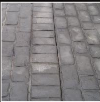
Cutstone Bård tillsammans med sliten gatsten. Stenstorlek ca 10 x 20 cm. Mönstret finns som gummimatris.
