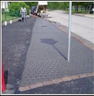
Smågatsten i förband. genomfärgad betong med 2 % svart pigment. Mönstret finns på rulle.
